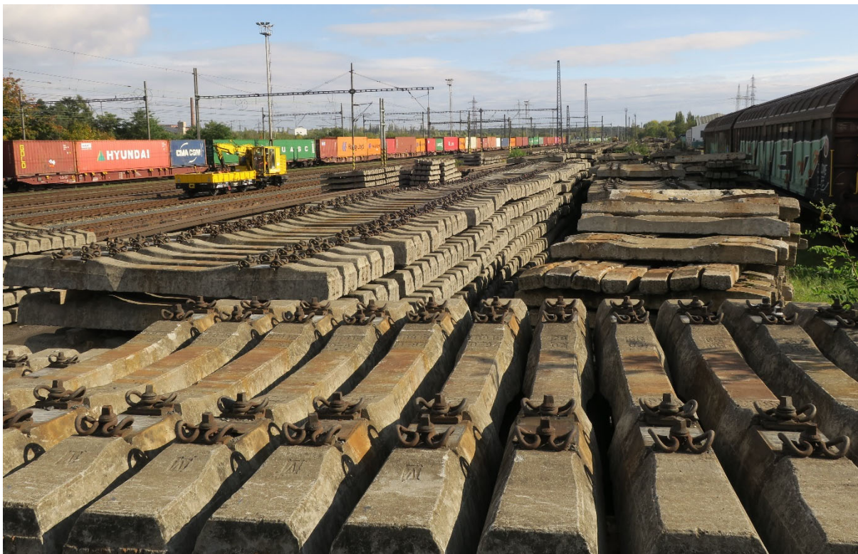
Obr. 3 – Uložení výzisku z úseku Poříčany – Velim v žst. Běchovice
