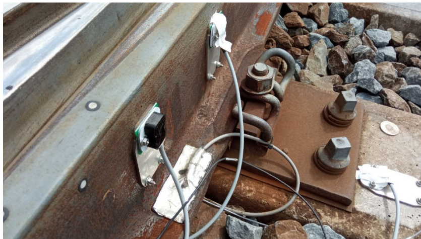
Obr. 4 – Testování různých snímačů na srdcovce výhybky
